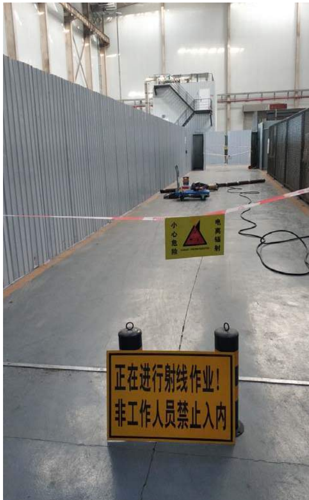
现场作业控制区和监督区分区警戒线
