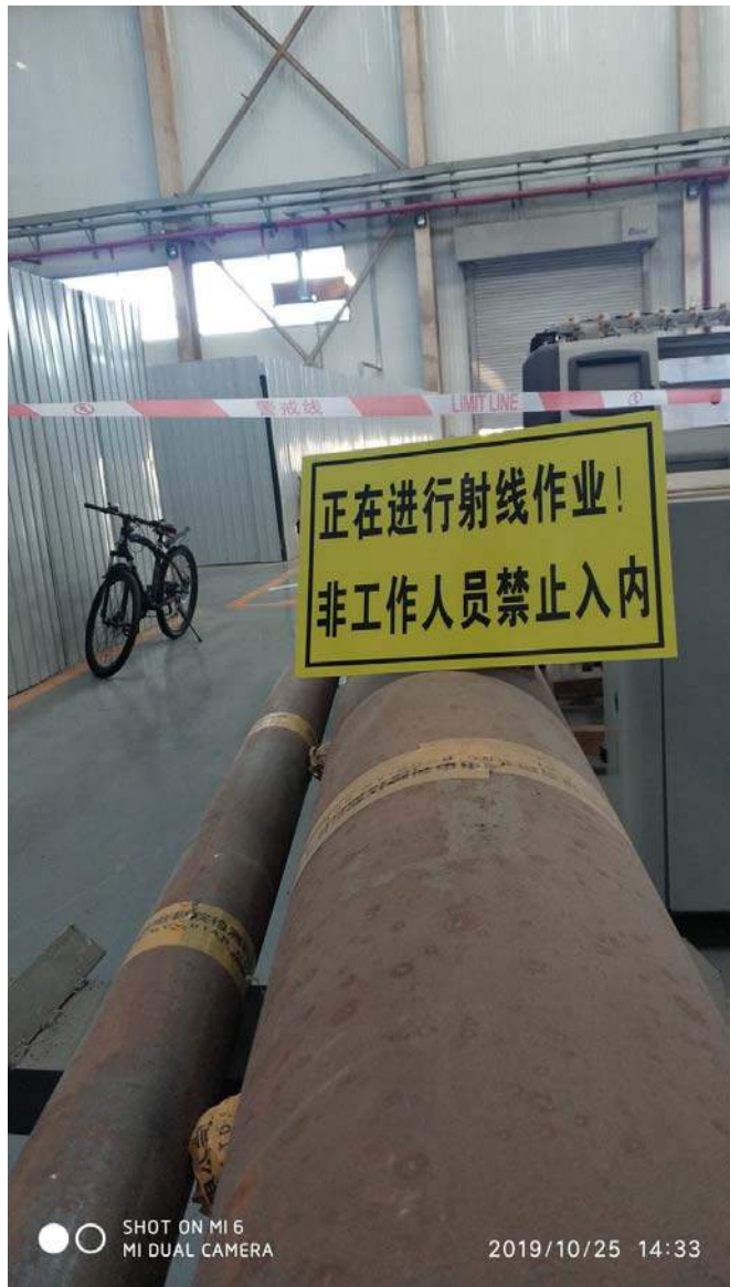
现场作业警示牌和警戒线
